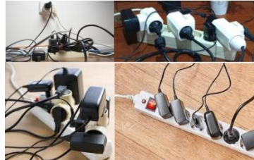
Gambar 9. Tumpukan steker pada stop kontak
