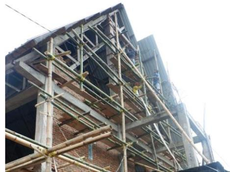
**Gambar: Proses kerja yang sementara dipasang batu bata.**
