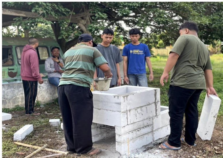
Gambar 4. Proses perakitan dimulai dengan menyusun hebel
